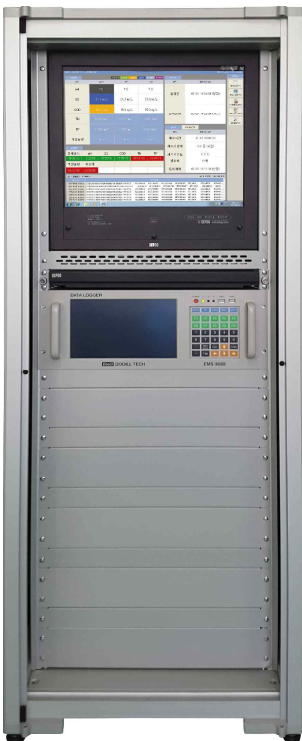
전면 Rack 조립 사진
